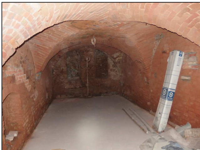
Pomieszczenia w piwnicy
