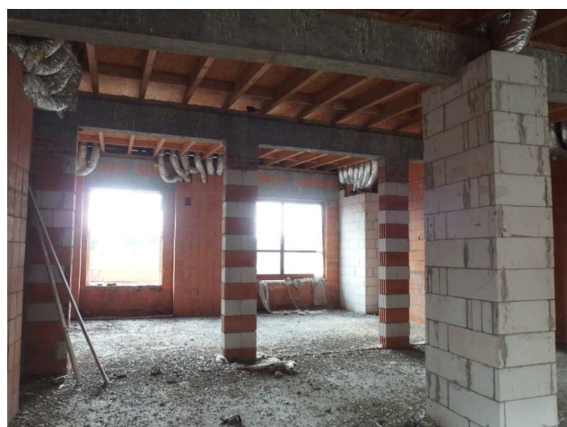
Widok fragmentu IV piętra
