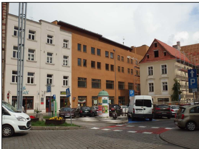
Widok budynku od frontu
