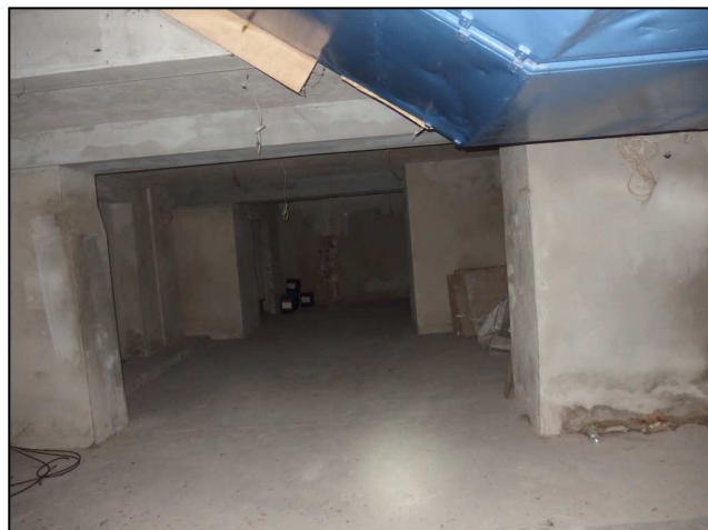
Pomieszczenia w piwnicy
