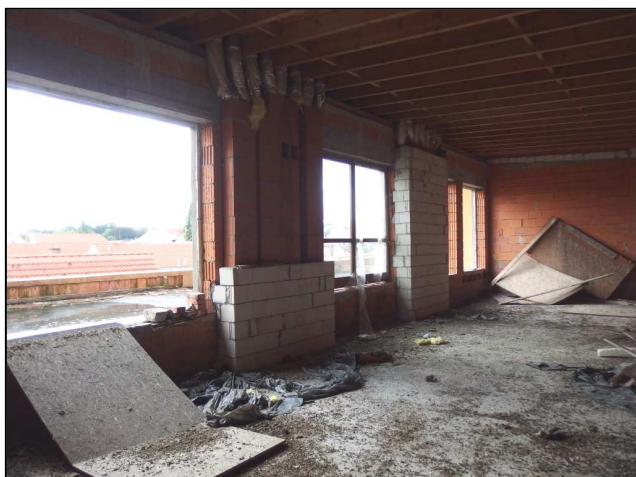
Widok fragmentu IV piętra
