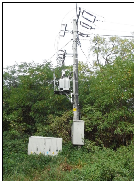
14 – Trafostacja słupowa
