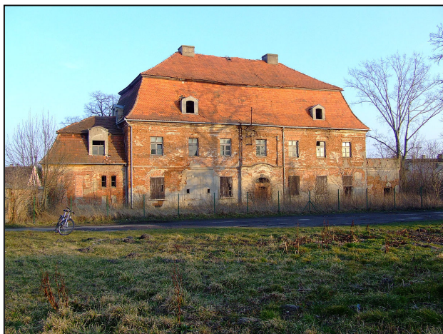
1 - Widok pałacu, zdjęcie z 2014 r.
