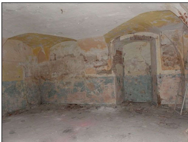
5 - Pomieszczenie na parterze
